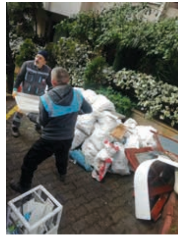
Hafriyat Toprağı ile İnşaat Yıkıntı Atıklarının Toplanması ve Ruhsatlı Döküm Sahasına Taşınması
