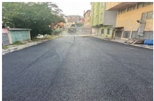
Mevlana Mahallesi Şebnem Sokak Asfalt Kaplama Çalışması
