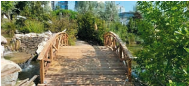
Parklarda Bakım Onarım Çalışması (Mimar Sinan Parkı Ahşap Köprü Yenileme Çalışması)
