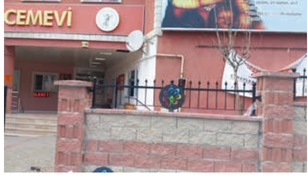
İçerenköy Cem Evi Duvar Yapım İşi
