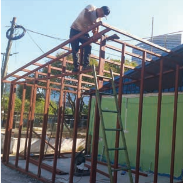
Ataşehir Hayvan Barnağı Ameliyathane Yapım İşi
