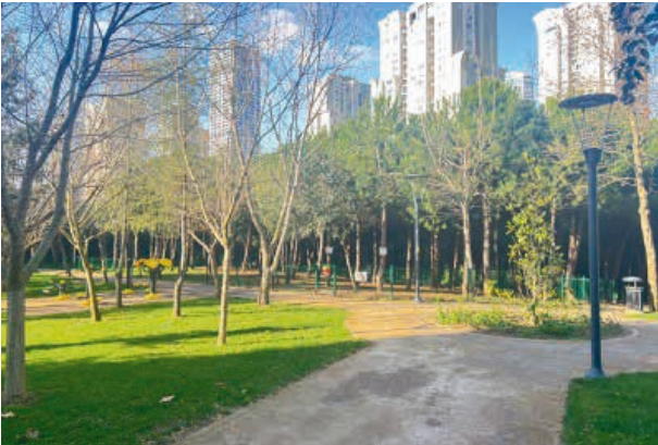
Yeni Park Yapımı-Küçükbakkalköy Mahallesi Paidar Demir Parkı
