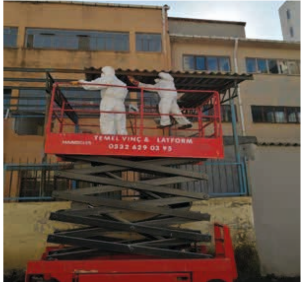
Asbest Numune Alımı
