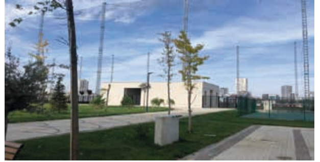
Kent Park Yapım İşi
