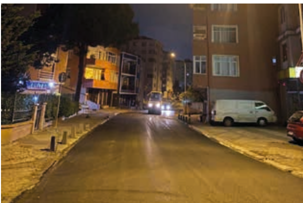
Küçükbakkalköy Mahallesi Merdivenköy Yolu Caddesi Asfalt Kaplama Çalışması
