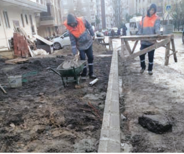
Örnek Mahallesi Dr. Suphi Ezgi Sokak Kaldırım İmalatı
