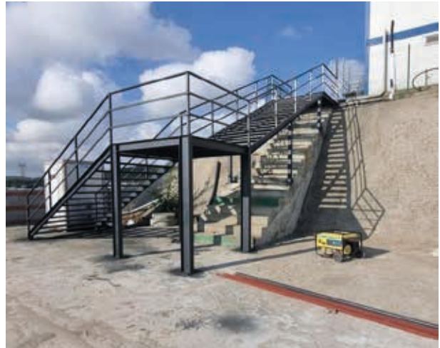
Temizlik İşleri Müdürlüğü Çelik Merdiven Yapım İşi
