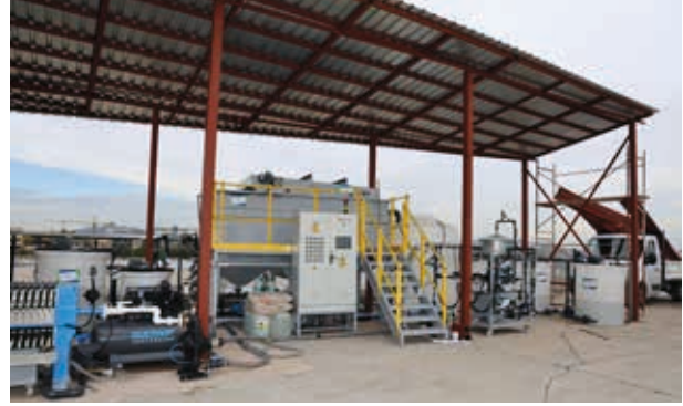
Atık Su Arıtma Tesisi
