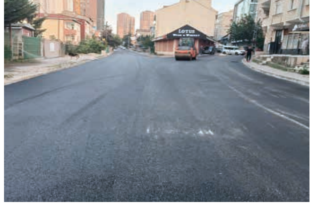
Barbaros Mahallesi Mimar Sinan Caddesi Asfalt Kaplama Çalışması
