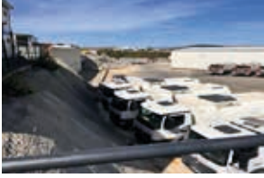
Temizlik İşleri Ferhatpaşa Şantiyesi
