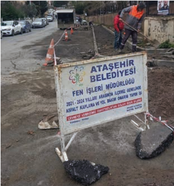
İçerenköy Mahallesi Yeşil Belde Sokak Kaldırım İmalatı
