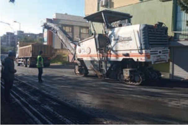
Ferhatpaşa Mahallesi 46. Sokak Asfalt Kaplama Çalışması
