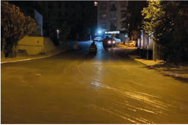
Küçükbakkalköy Mahallesi Başöğretmen Caddesi Asfalt Kaplama Çalışması
