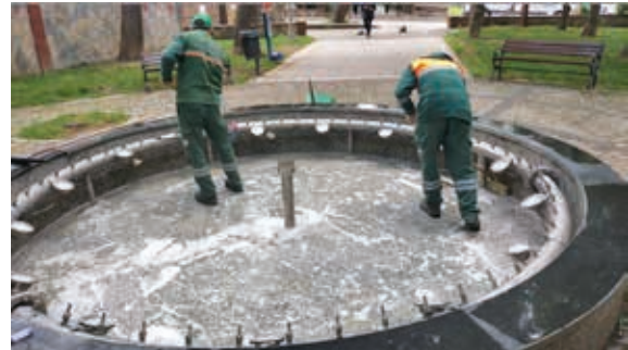
Parklarda Süs Havuzu Temizliği Yapılması
