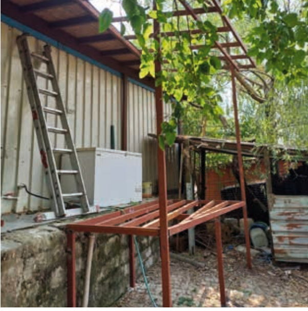
Veteriner İşleri Müdürlüğü Sundurma Yapım İşi
