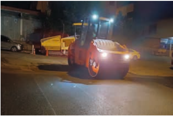
Kayışdağı Mahallesi Kıbrıs Caddesi Asfalt Kaplama Çalışması
