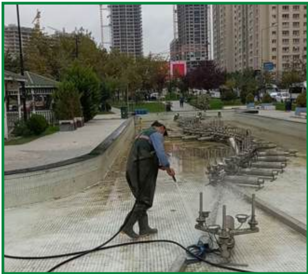
Parklarda Süs Havuzu Temizliği Yapılması
