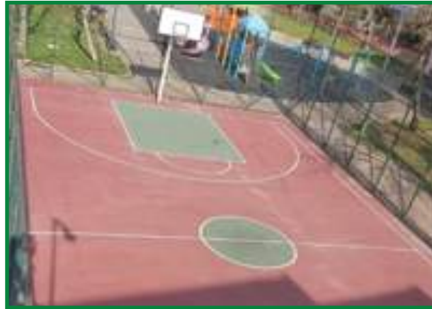
G- 30 Parkı Basketbol Sahasının Akrilik Zemin Kaplama Malzemesi İle Kaplanarak Yenilenmesi
