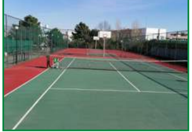
1.Basketbol Sahasının Akrilik Zemin Kaplama Malzemesi İle Kaplanarak Yenilenmesi
