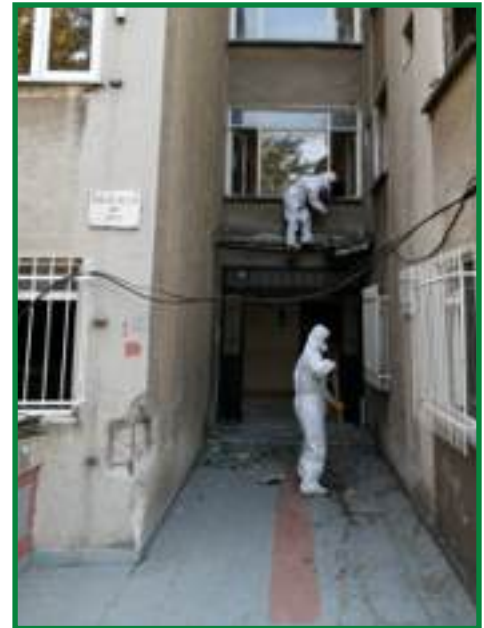
Asbest numune alımı
