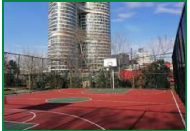
İpek Parkı Basketbol Sahasının Akrilik Zemin Kaplama Malzemesi İle Kaplanarak Yenilenmesi
