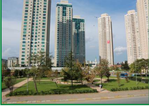
Tamamen Yenilenen Emekevler Parkı 1. Kısım
