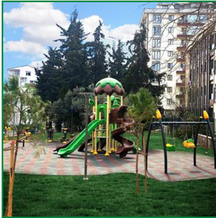
Çocuk oyun grubu ve açık alan spor aletleri montajı ve zemininin kauçukla kaplanması çalışması (Örnek Mahallesi Pazar Alanı Yeşil Alan)
