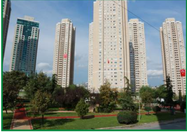
Tamamen Yenilenen Emekevler Parkı 2. Kısım
