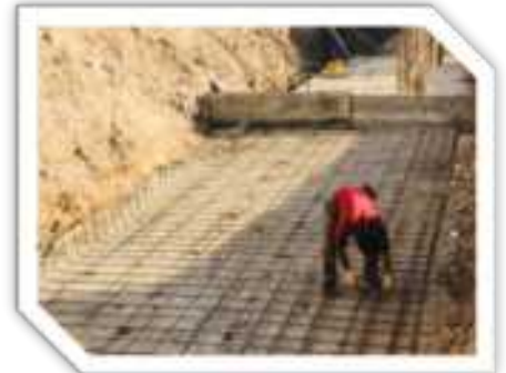
Atatürk Mahallesi Atapark Caddesi Betonarmerme Perde Duvar İmalatı
