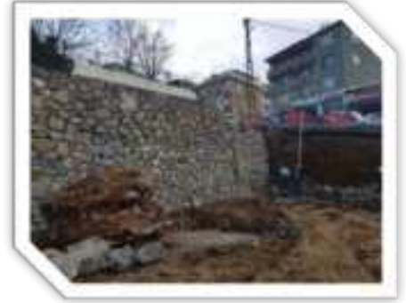
Aydın Doğan Güzel Sanatlar Lisesi Taş Duvar İmalatı
