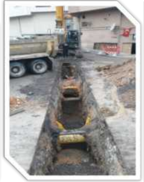
Örnek Mahallesi Erfelek Sokak Yağmursuyu Kanalı Çalışması
