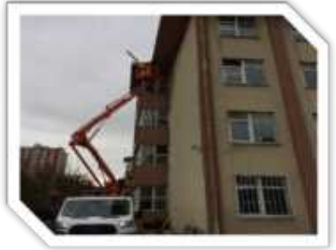
İbrahim Müteferrika Meslek Lisesi Yağmur İniş Boruları Tamirati
