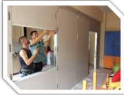
İhsan Kurşunlu Ortaokulu Bölme Duvarları İmalatı
