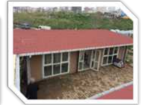
Hayvan Barınağı profil demirinden sundurma imalatı ve çatı kaplaması yapılması
