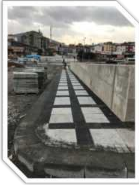
Atatürk Mahallesi Atapark Caddesi İstinat Duvarı ve Tretuvar Çalışması
