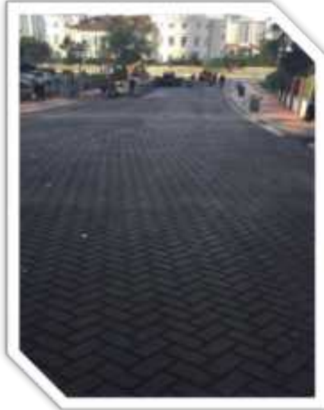
Atatürk Mahallesi Baskı Asfalt Çalışmaları
