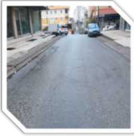
Kayışdağı Mahallesi Atilla Caddesi İlk Hali
