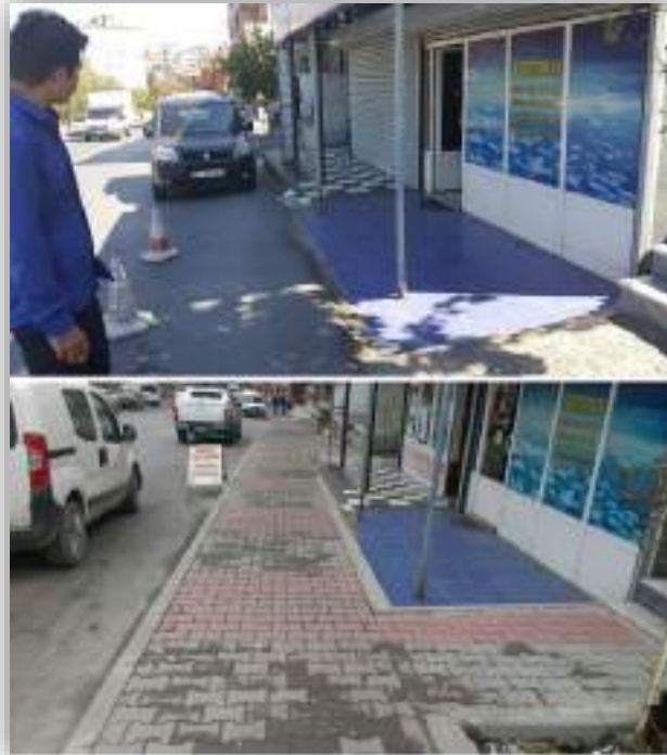
Mevlana Mahallesi Sakarya Caddesi Eski ve Yeni Hali
