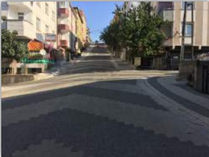
İnönü Mahallesi Piri Mehmetpaşa Sokak Parke Kaplama Çalışması
