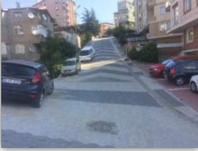
İnönü Mahallesi Hülyalı Sokak Parke Kaplama Çalışması
