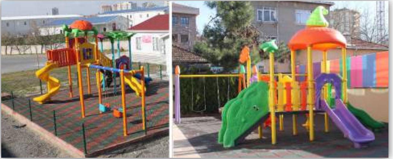
Okullarda çocuk oyun grubu montajı ve zemine kauçuk kaplama çalışması
