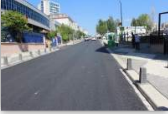
Küçükbakkalköy Mahallesi Merdivenköy Yolu Caddesi Asfalt Çalışması
