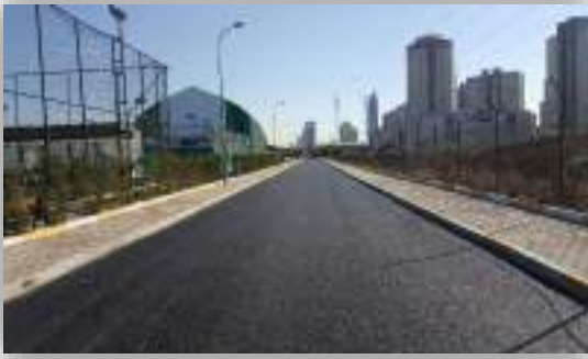
8/Barbaros Mahallesi Lale Sokak Asfalt Çalışması
