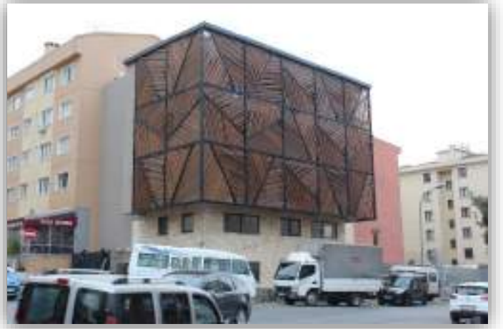
Küçükbakkalköy Emekli Dinlenme Evi İnşaatı
