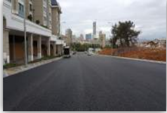
Atatürk Mahallesi Atapark Caddesi Asfalt Çalışması
