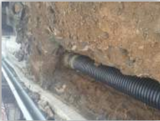
İlçemiz Geneline Yağmursuyu Kanalı Çalışması
