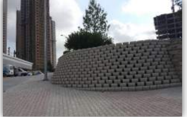
Atatürk Mahallesi Fazlıpaşa Sokak Kaldırım Çalışması
