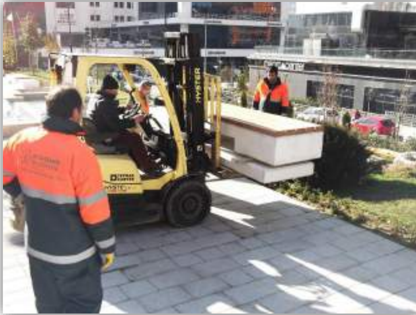
Kent Mobilyaları Temini ve Montajı
