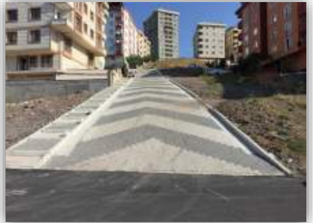
İnönü Mahallesi Osmancık Sokak Parke Kaplama Çalışması
