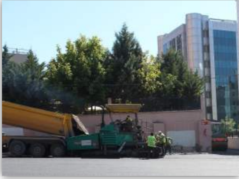
Küçükbakköy Mahallesi Tevfik Fikret Caddesi Asfalt Çalışması
