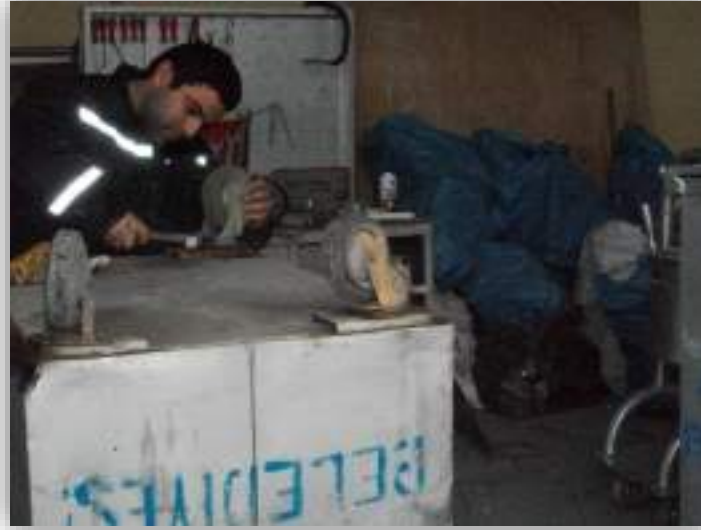
0,8 m 3 (800 litre) yerüstü konteyneri tamiri
