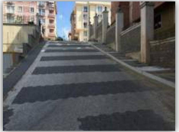
İnönü Mahallesi Manolya Sokak Parke Kaplama Çalışması
