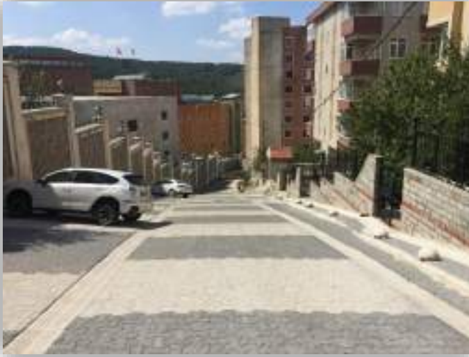
İnönü Mahallesi Menba Sokak Parke Kaplama Çalışması
