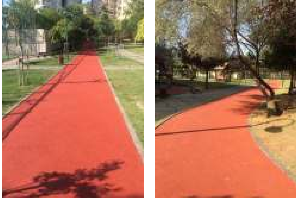
Fetih Mahallesi Buhara Parkı yürüme yolu yenileme çalışması
