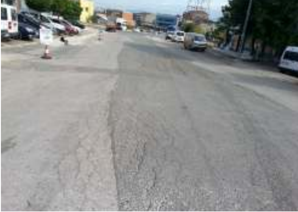
Ferhatpaşa Mahallesi G-2 Sokak asfalt çalışması-eski hali
