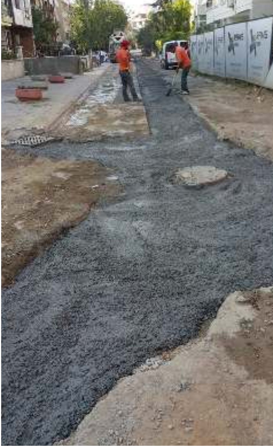
İlçemiz genelinde yapılan yağmur suyu kanalı çalışmaları
