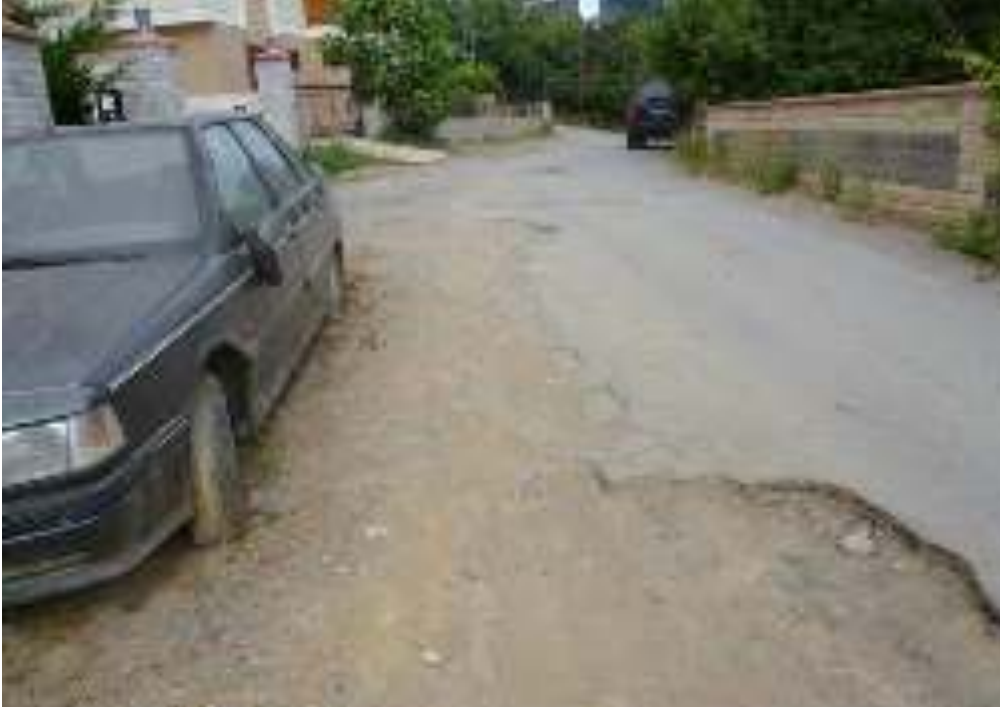
Küçükbakkalköy Mahallesi Mororkide Sokak asfalt çalışması-eski hali
