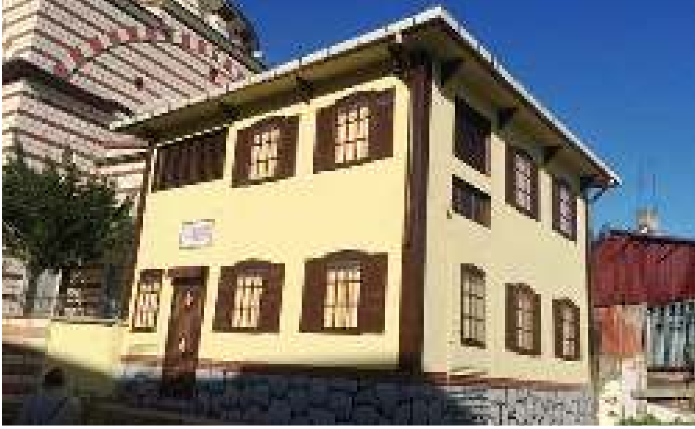
Trafo binalarının giydirilmesi (yeni hali)
