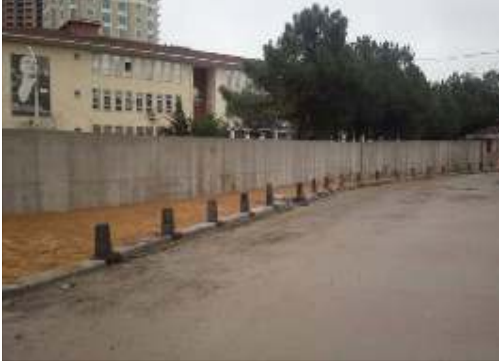
Atatürk Mahallesi Cemile Besler İlköğretim Okulu istinat duvarı çalışması
