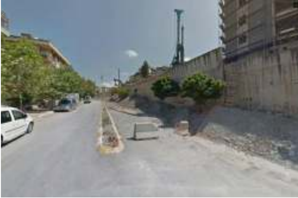
İçerenköy Mahallesi Topçu Caddesi istinat duvarı çalışması – eski hali
