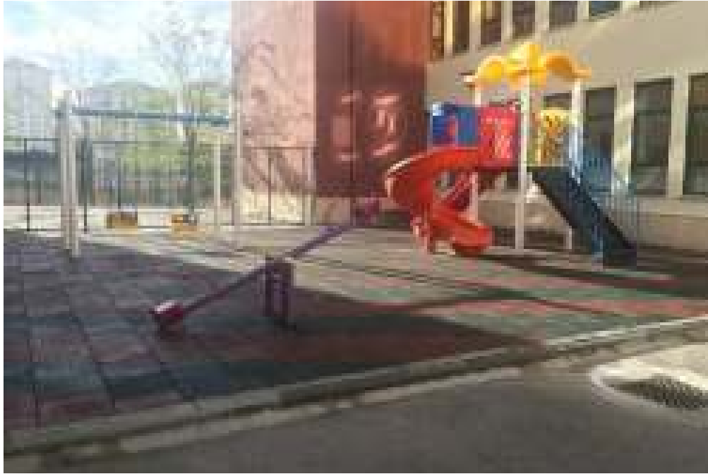
Okullarda çocuk oyun grubu montajı ve zemine kauçuk kaplama çalışması (Hasan Akan İlköğretim Okulu)
