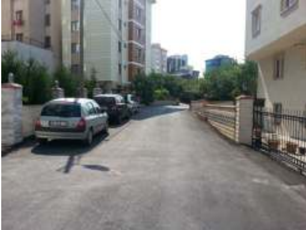
Küçükbakkalköy Mahallesi Mororkide Sokak asfalt çalışması-yeni hali
