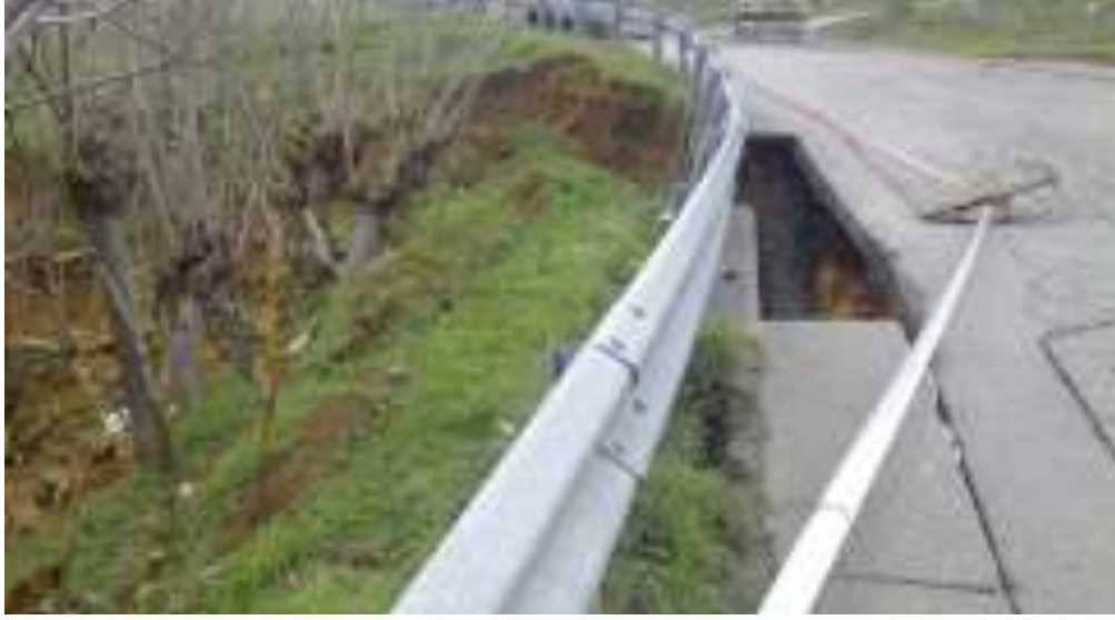
Barbaros Mahallesi Barbaros Caddesi istinat duvarı çalışması- eski hali
