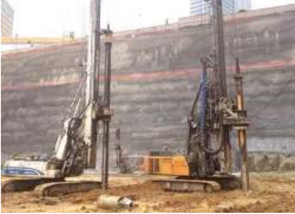
Temel altı zemin iyileştirmesi, fore kazık çalışması
