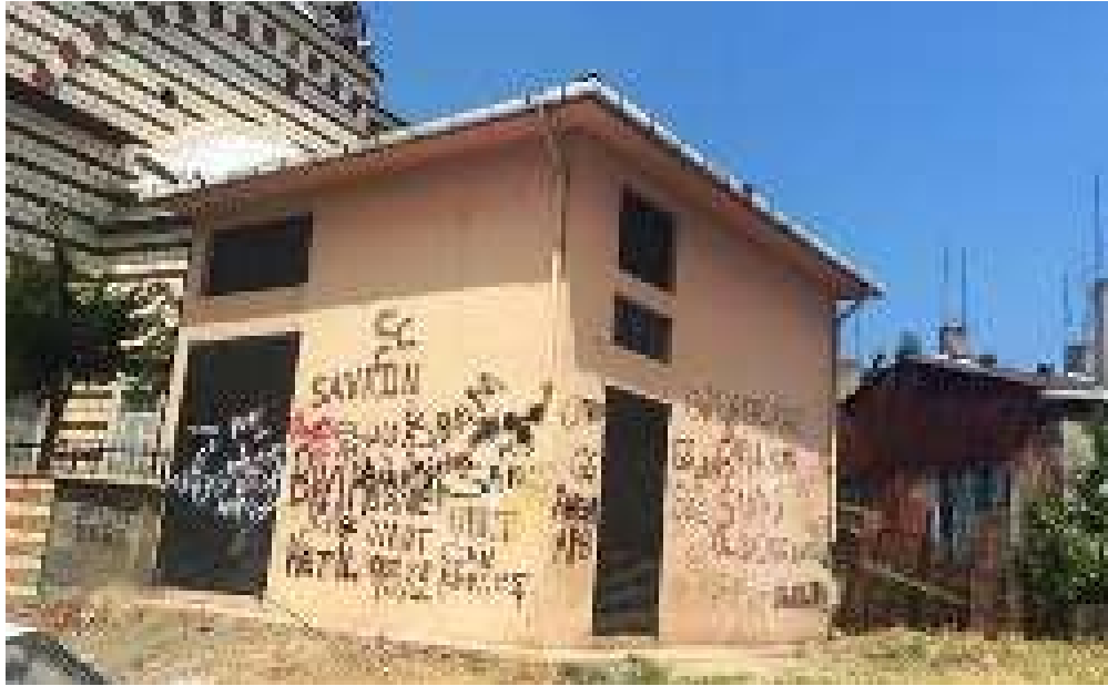
Trafo binalarının giydirilmesi (eski hali)
