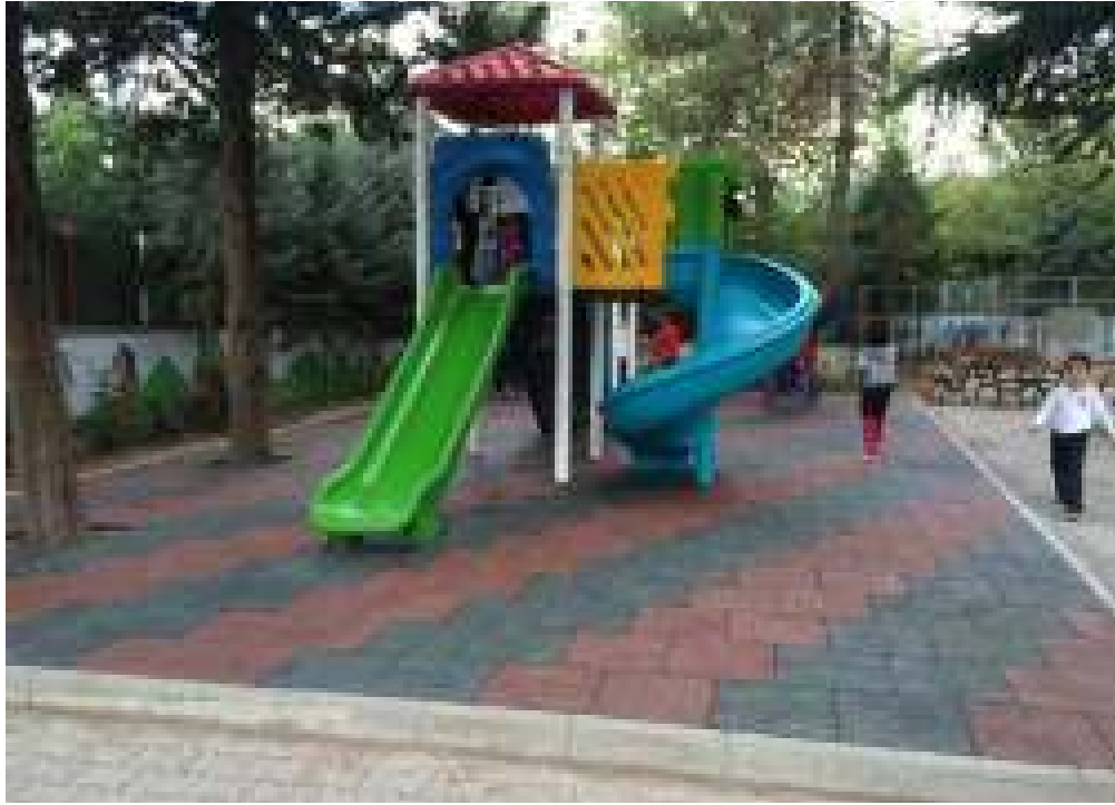
Okullarda çocuk oyun grubu montajı ve zemine kauçuk kaplama çalışması (Kadriye Faik Koparan İlkokulu)
