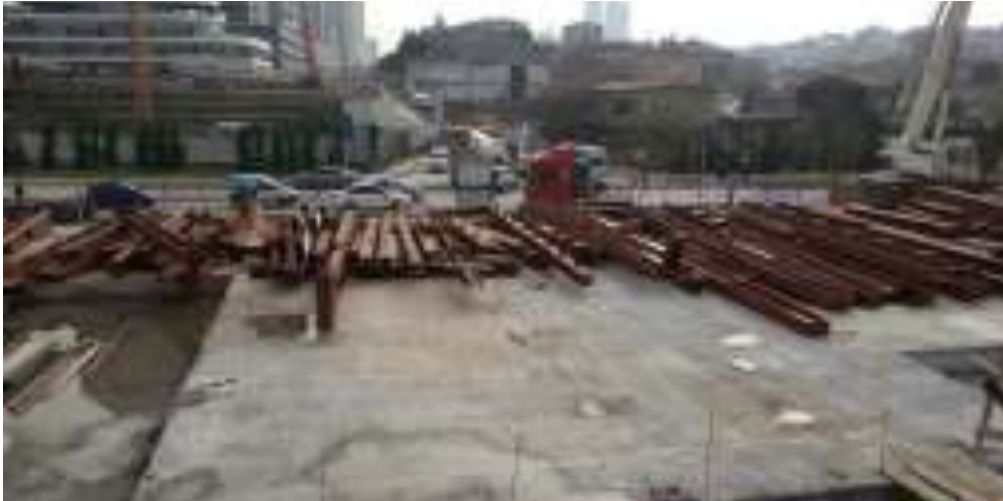
Erdal Eren Kültür tesisi inşaatı
