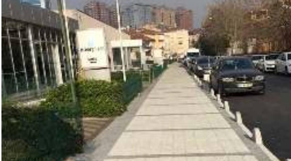
İçerenköy Mahallesi Erkut Sokak bordür tretuar çalışması
