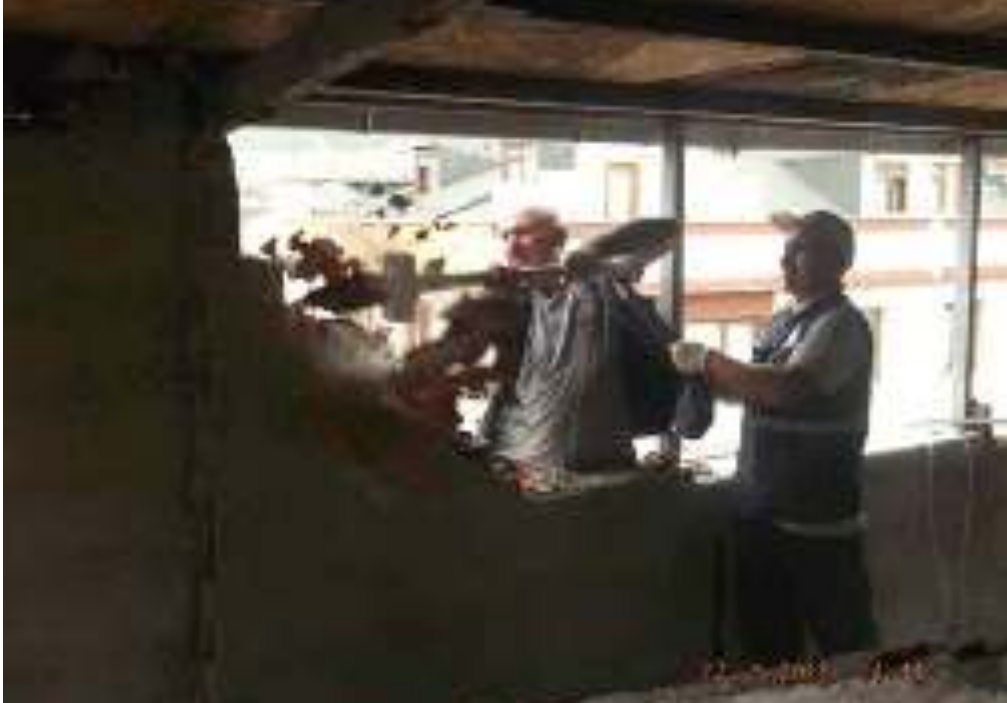
Kayışdağı Mahallesi'nde kaçak yapılmış olan katın yıkımı
