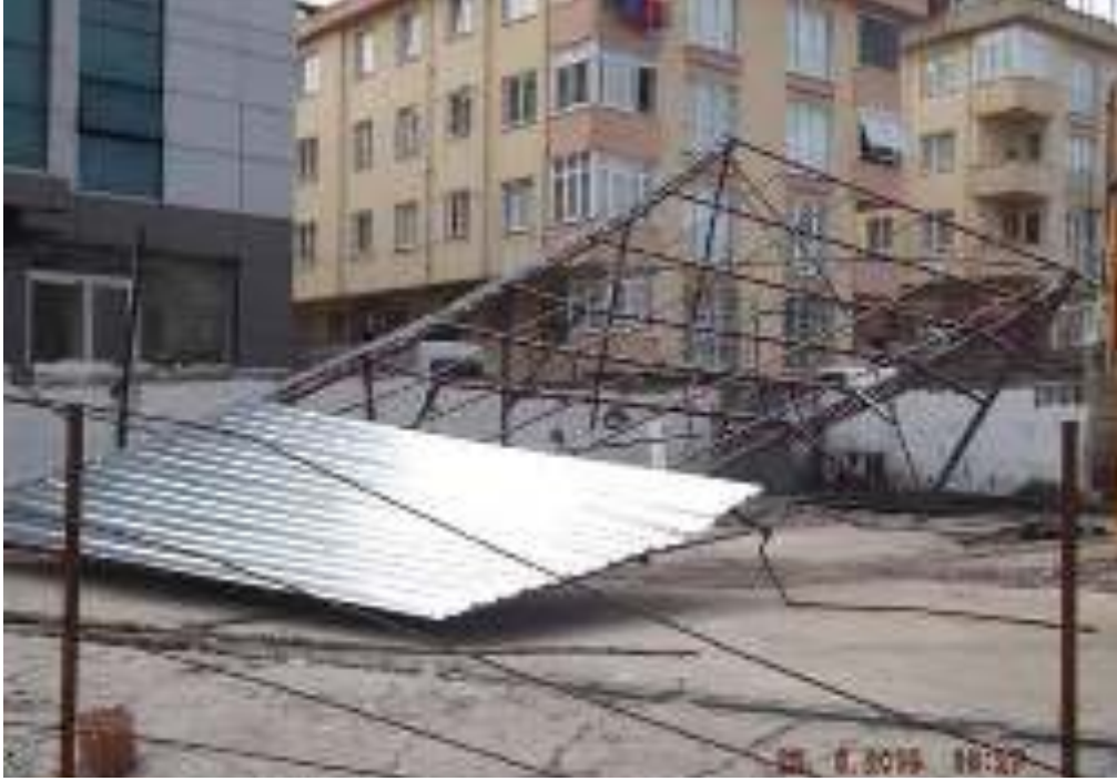
Kayışdağı Mahallesi'ndeki kaçak yapının yıkımının gerçekleşmesi
