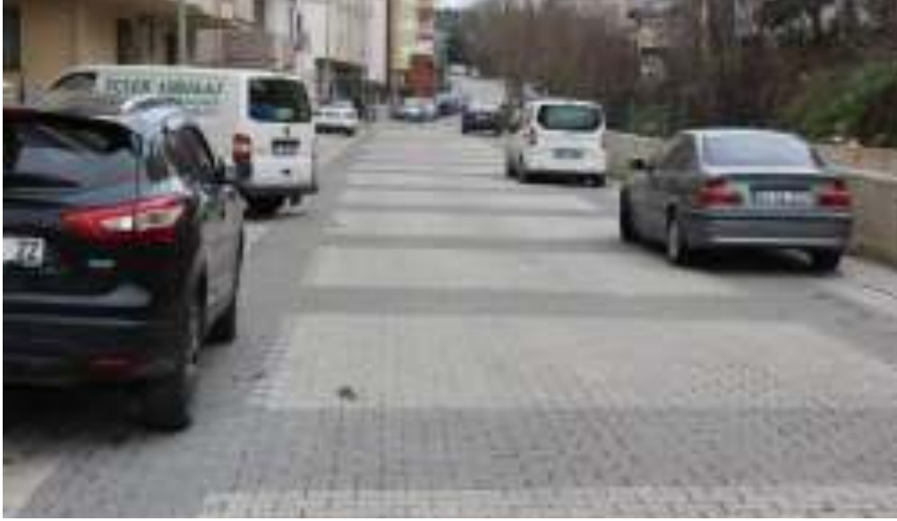
Aşık Veysel Mahallesi Nuri Pakdil Sokak parke kaplama çalışması
