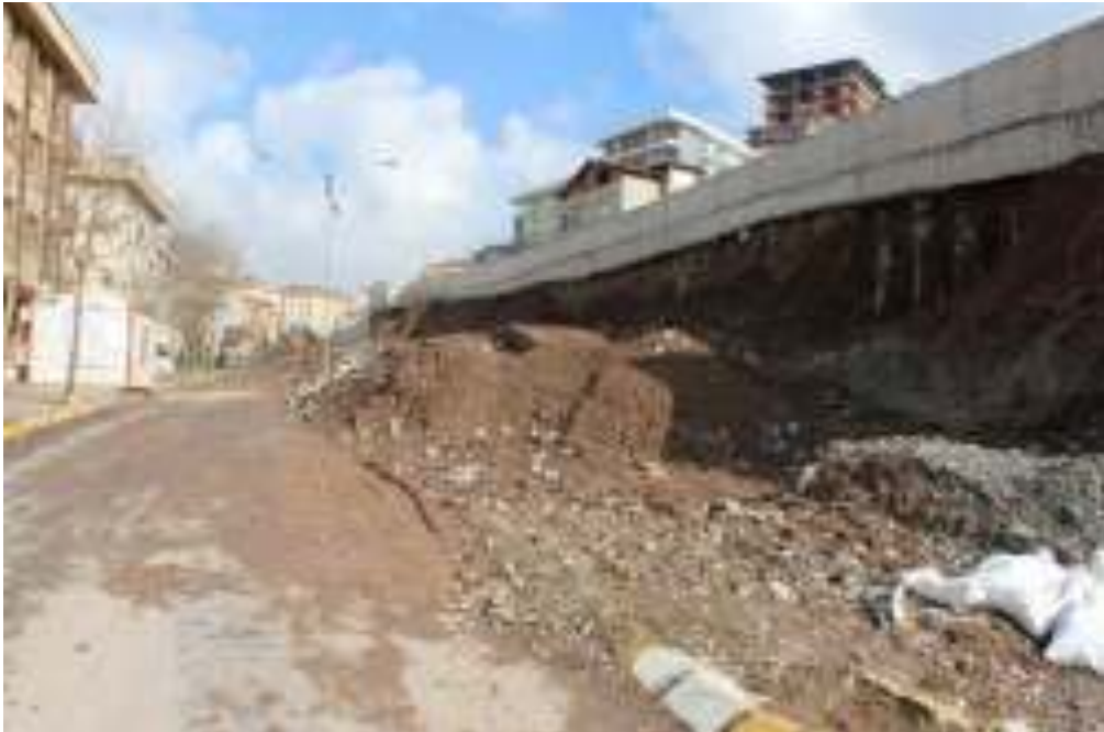
İçerenköy Mahallesi Topçu Caddesi'nde halen devam eden istinat duvarı çalışması
