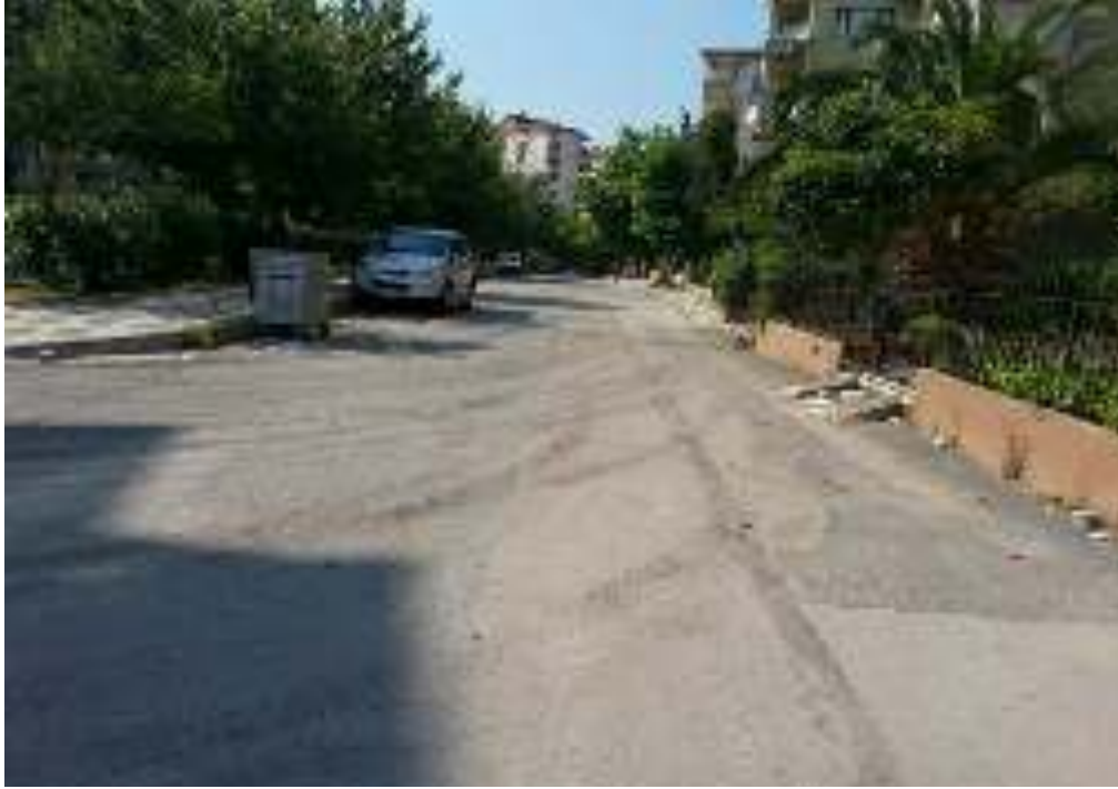
İçerenköy Mahallesi Esin Sokak asfalt çalışması-eski hali
