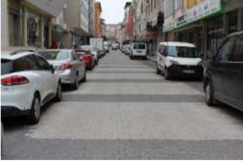
Fetih Mahallesi Kösebey Sokak parke kaplama çalışması
