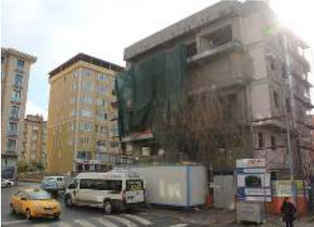
Küçükbakkalköy Emekli Dinlenme Evi İnşaatı
