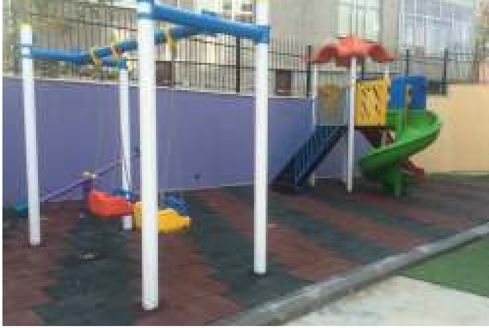
Okullarda çocuk oyun grubu montajı ve zemine kauçuk kaplama çalışması (Şerife Bacı Anaokulu)
