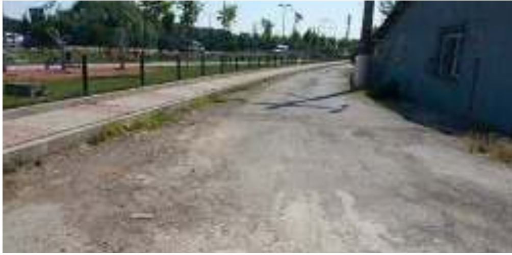
Yeni Çamlıca Mahallesi Balabanbey Sokak asfalt çalışması-eski hali
