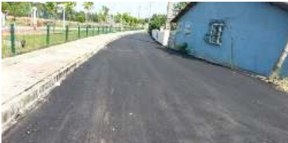
Yeni Çamlıca Mahallesi Balabanbey Sokak asfalt çalışması-yeni hali
