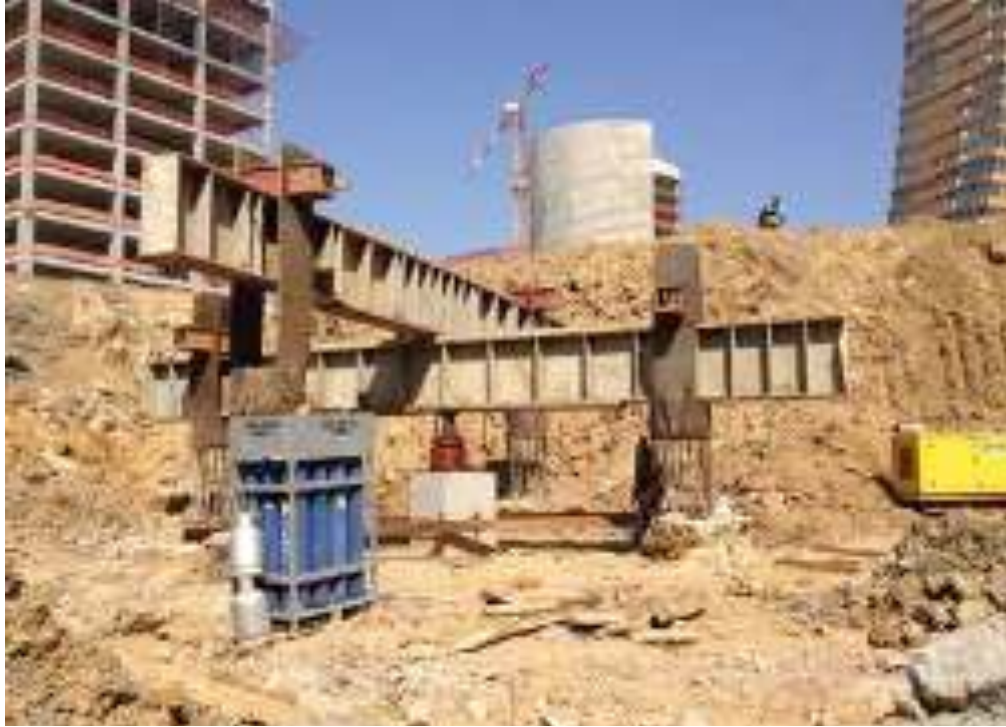
Kazık yükleme deneyi uygulaması kontrolü
