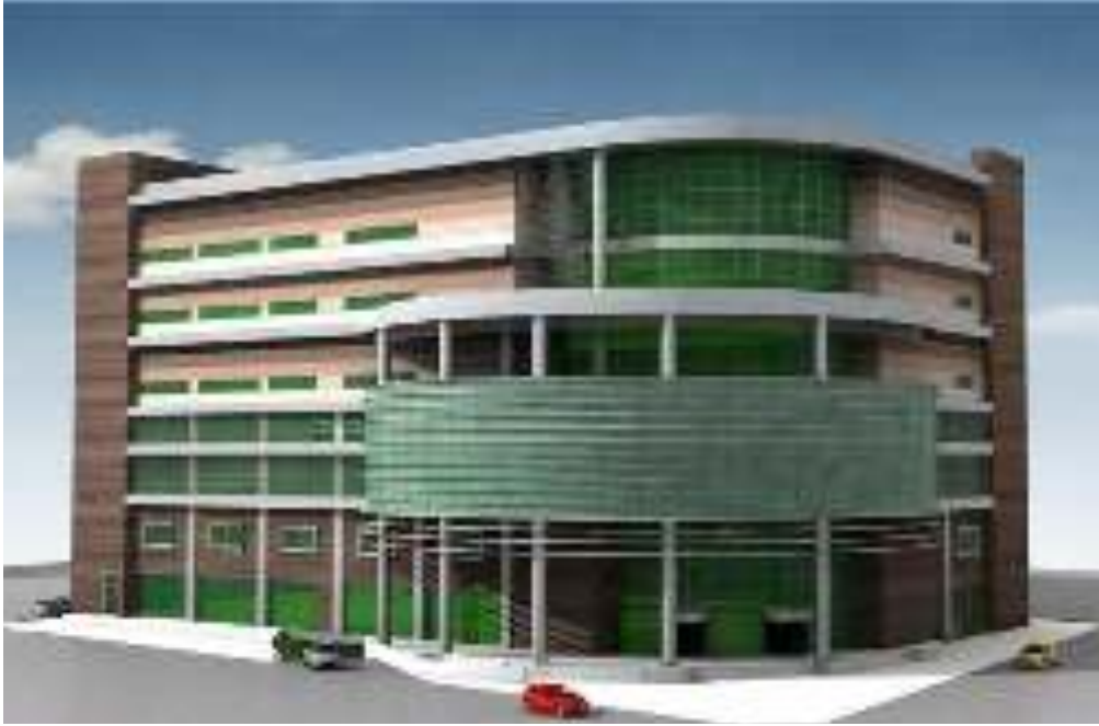
İçerenköy Kapalı Pazar Alanı ve Kültür Merkezi inşaatı
