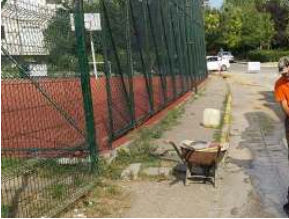
Örnek Mahallesi'nde yapılan yağmur suyu kanalı çalışması
