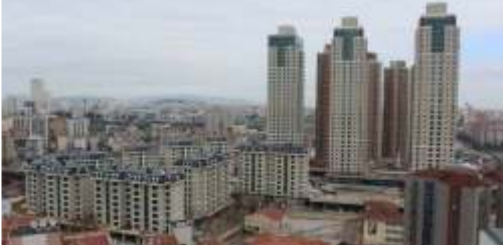
Atatürk Mahallesi Emekevler konut inşaatı
