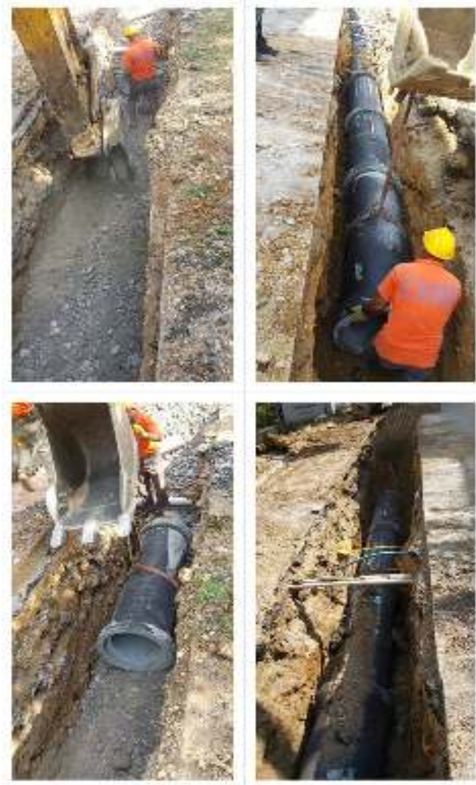
İlçemiz genelinde yapılan yağmur suyu kanalı çalışmaları
