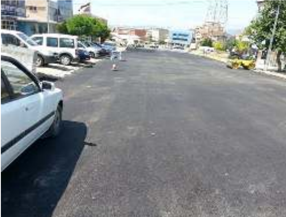
Ferhatpaşa Mahallesi G-2 Sokak asfalt çalışması-yeni hali
