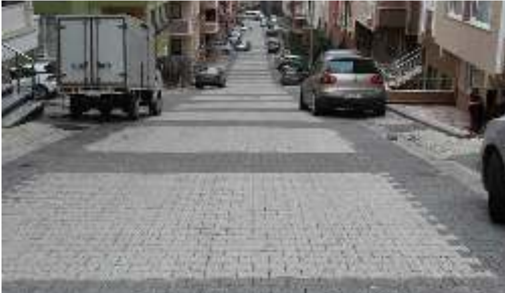
Aşık Veysel Mahallesi Beyaz Kumru Sokak parke kaplama çalışması
