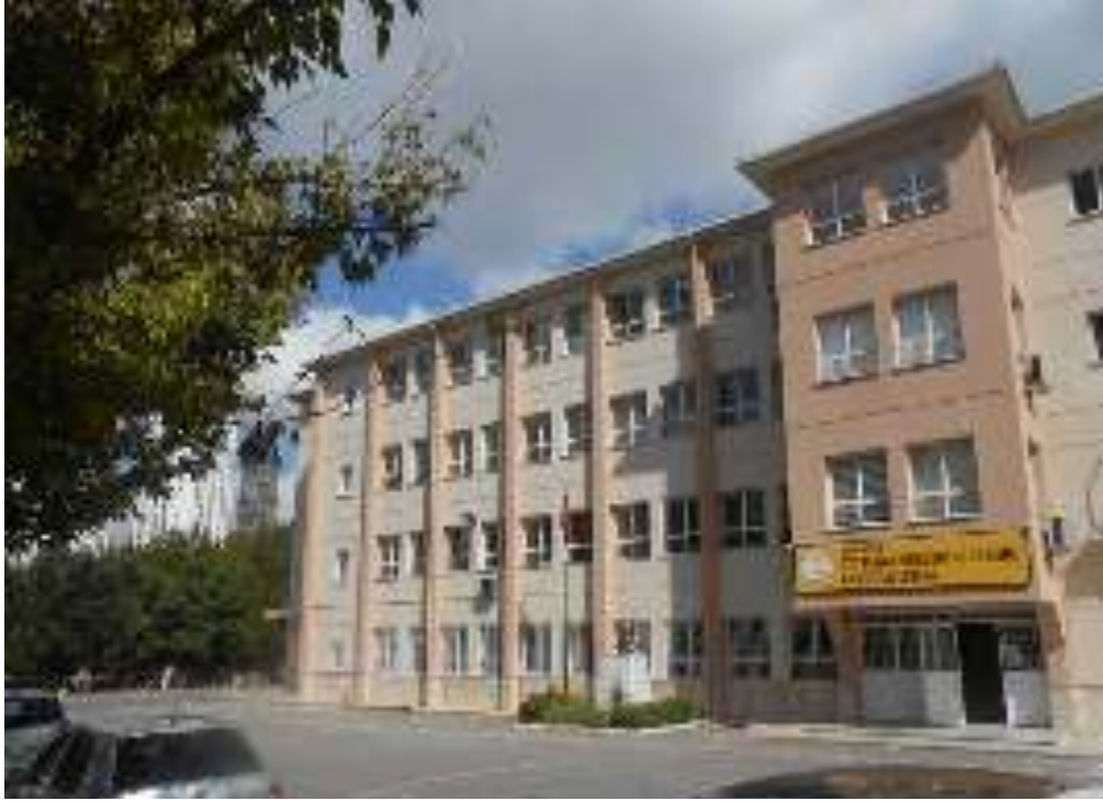
Ataşehir Mesleki ve Teknik Anadolu Lisesi dış cephe boya çalışması
