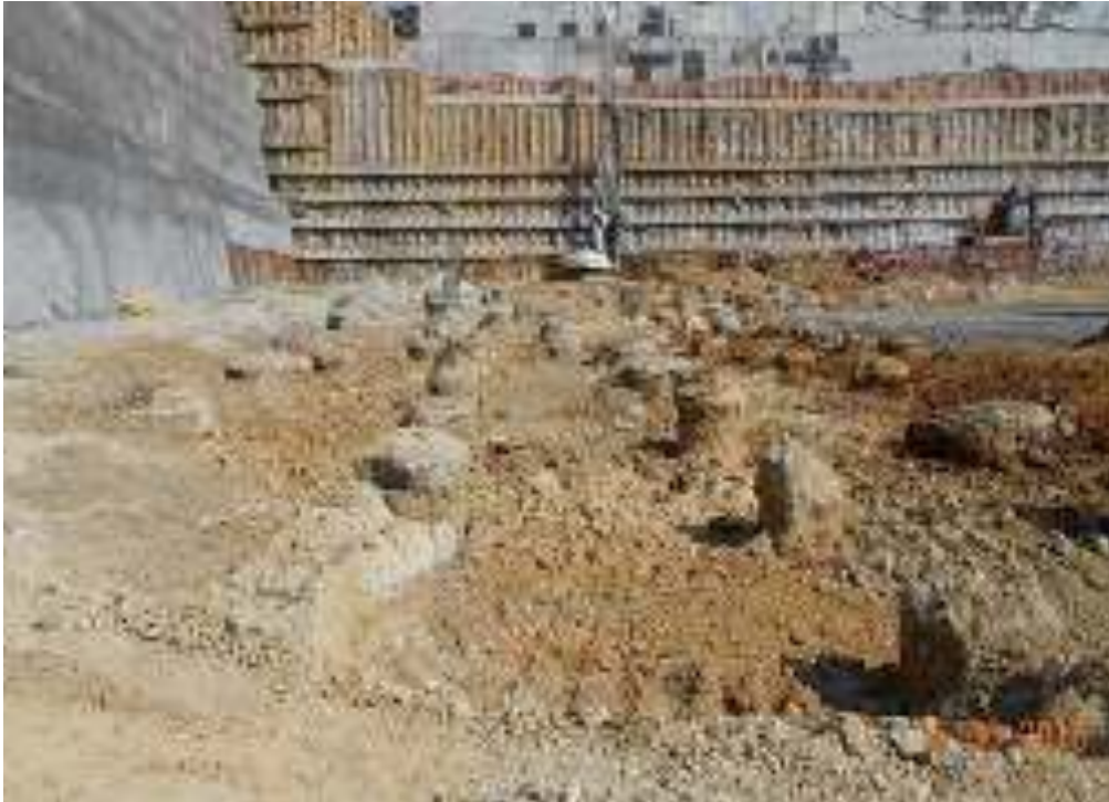
Fore kazık – ankraj uygulaması. Zemin iyileştirme ve iksa çalışması
