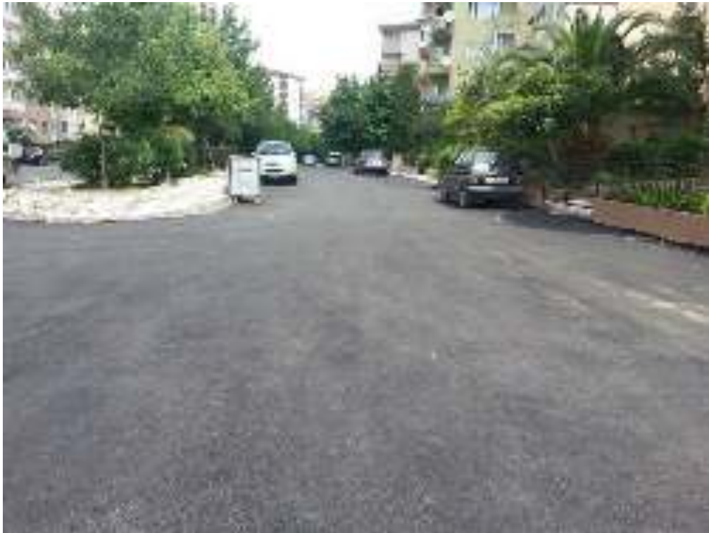
İçerenköy Mahallesi Esin Sokak asfalt çalışması-yeni hali
