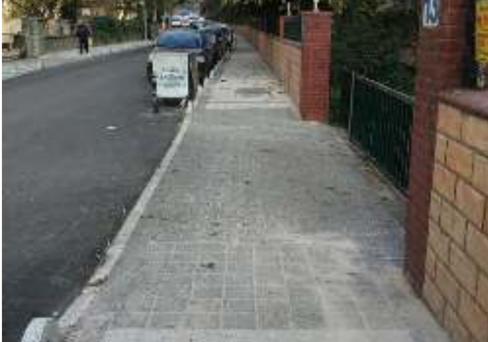
İçerenköy Mahallesi Umut Sokak bordür tretuvar çalışması
