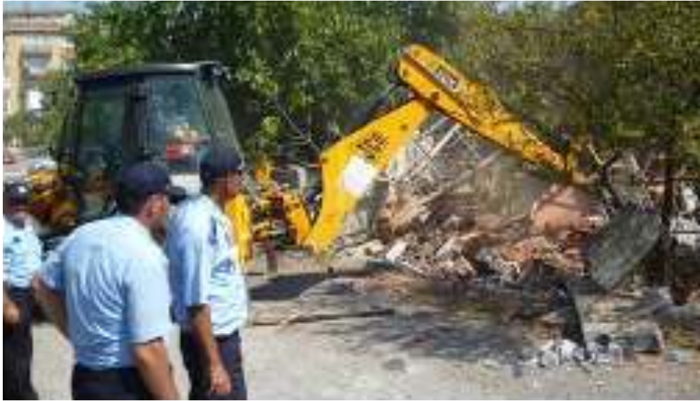
Gecekondu yıkım işlemleri
