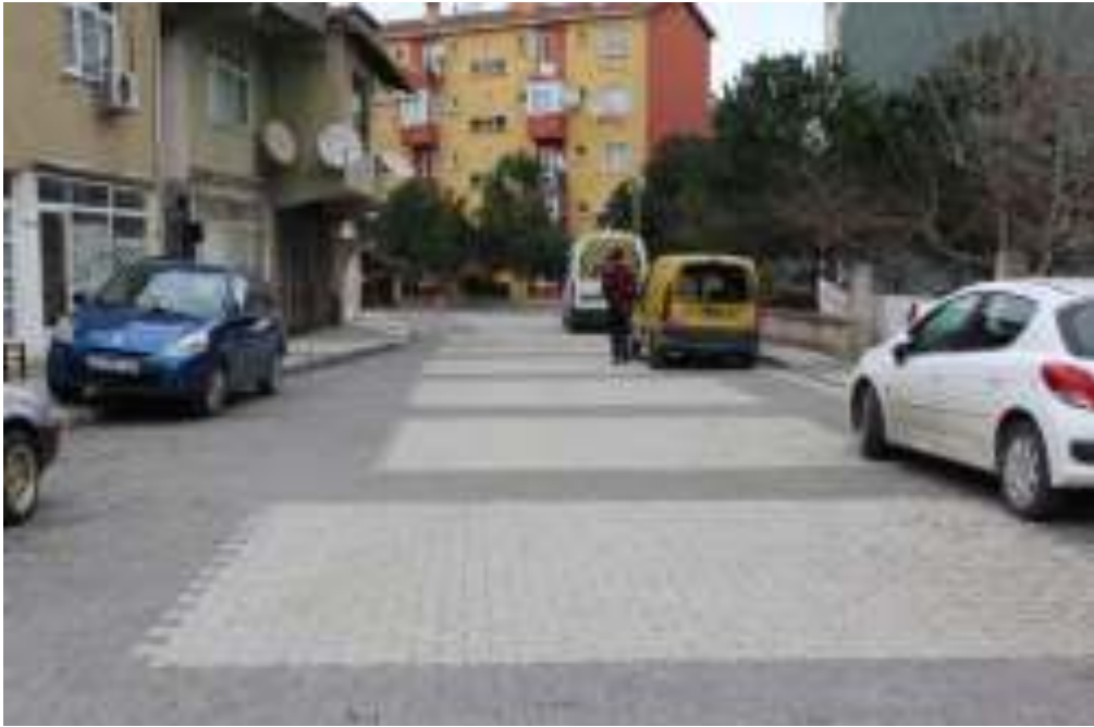
Örnek Mahallesi Dilara Sokak parke kaplama çalışması
