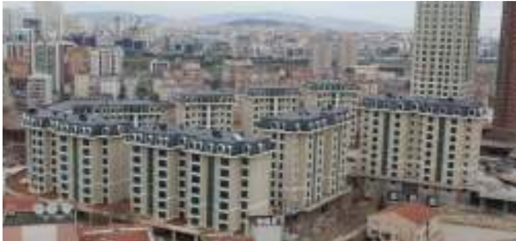
Atatürk Mahallesi Emekevler konut inşaatı
