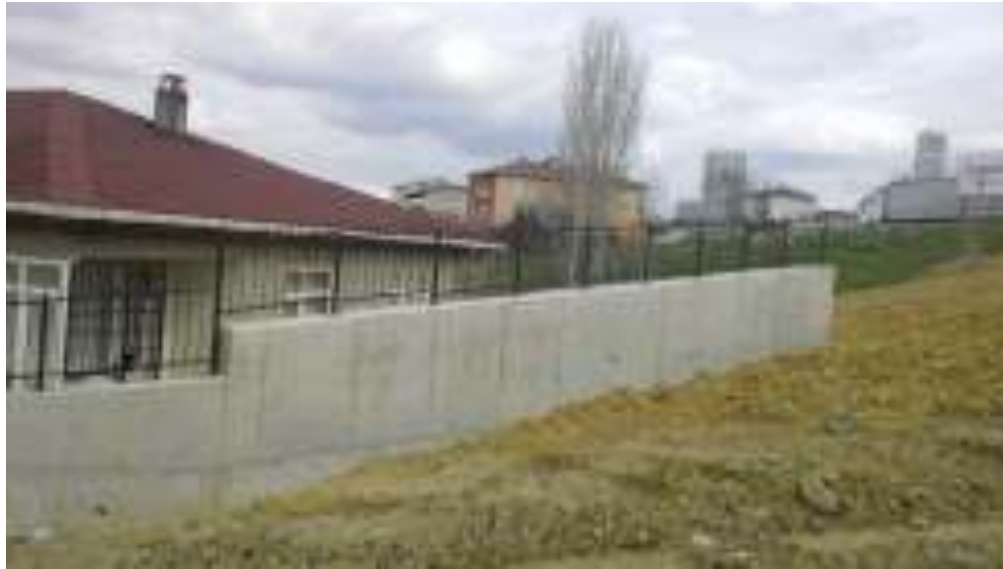
Barbaros Mahallesi Barbaros Caddesi istinat duvarı çalışması – yeni hali
