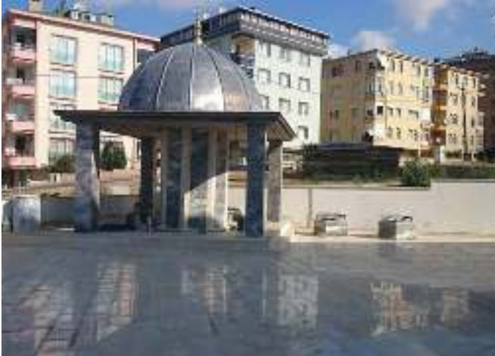
Hz. Ebubekir Sıddık Camii mermer kaplama çalışması
