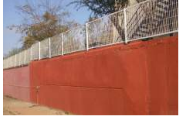
Barbaros Mahallesi Habire Yahşi Okulu İstinad Duvarı Çalışması
