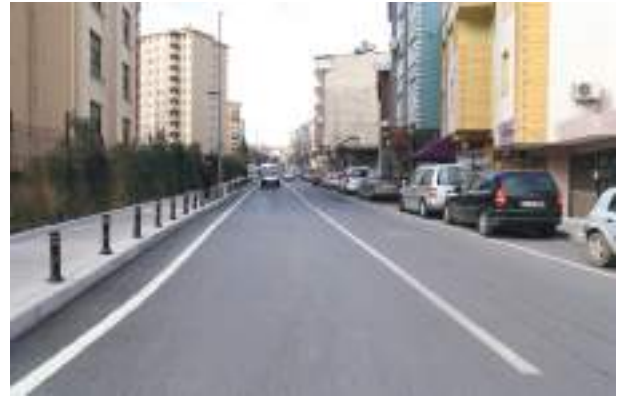
Fetih Mahallesi Kafkas Sokak Çalışma Sonrası
