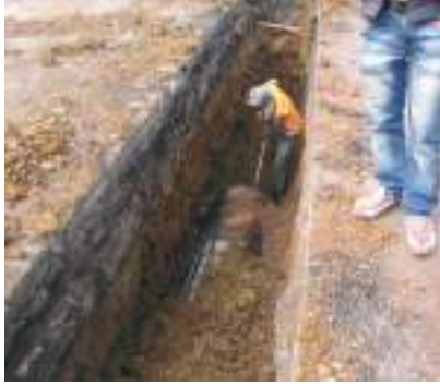
Ferhatpaşa Mahallesi Yağmursuyu Kanal Çalışması
