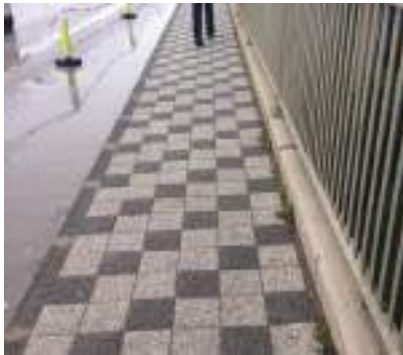
İçerenköy Mah. Değirmen Yolu Caddesi Kaldırım Çalışması
