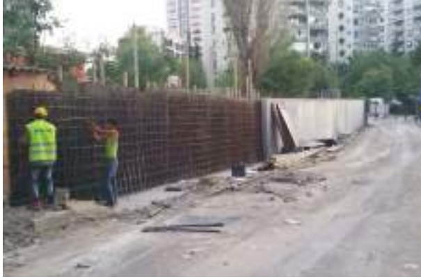
Atatürk Mahallesi Cemile Besler İlkokulu İstinad Duvarı Çalışması
