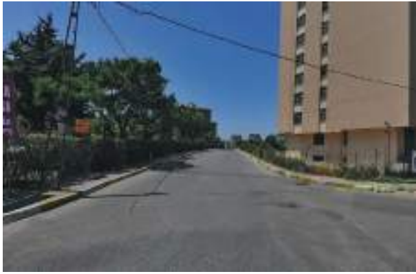
Fetih Mahallesi Tahralı Sokak Çalışma Öncesi
