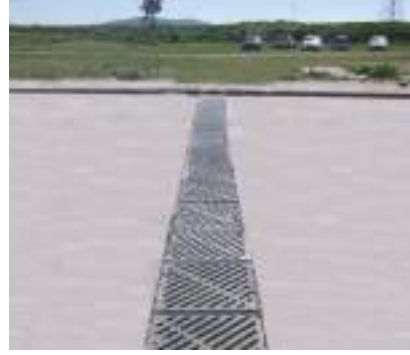
Ferhatpaşa Mahallesi Yağmursuyu Kanal Çalışması
