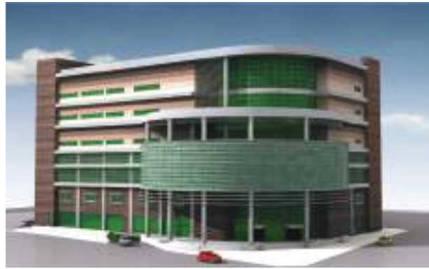
İçerenköy Kapalı Pazar Alanı ve Kültür Mrkz. İnşaatı
