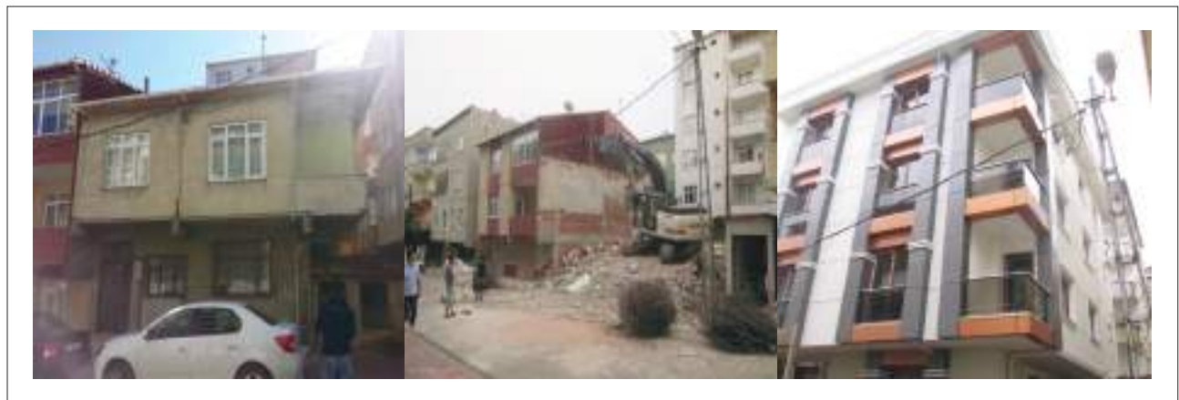
Mevcut Binanın Yıkım Öncesi Durumu
