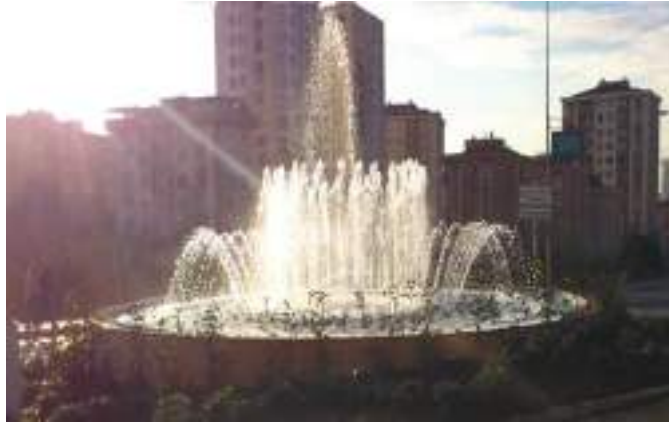
Küçükbakkalköy Mahallesi Süs Havuzu Yapımı
