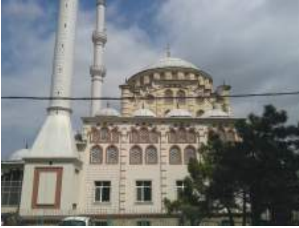
Örnek Mah. Türkiistan Camii Dış Cephe Boya İşlemleri
