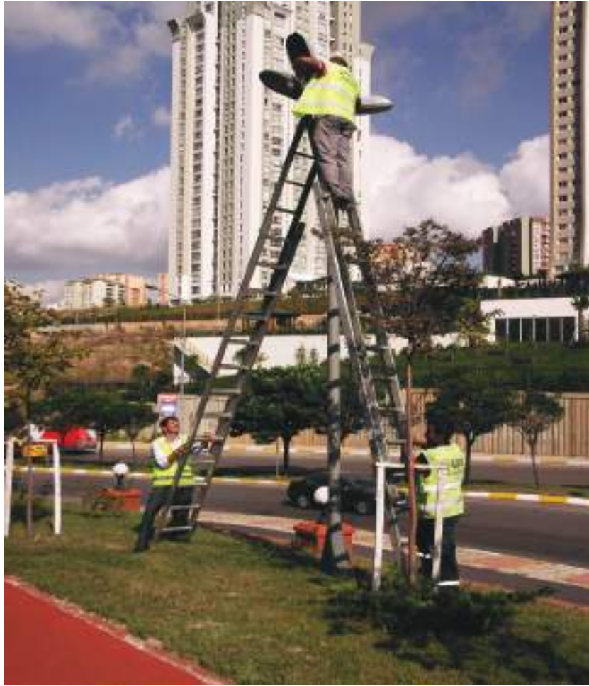
Park İçi Aydınlatma Onarımı Çalışması
