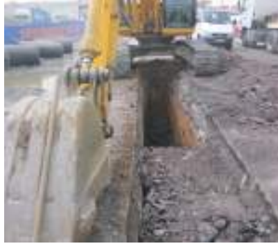
Ferhatpaşa Mahallesi Yağmursuyu Kanal Çalışması
